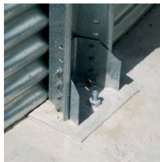
ENG. Detailed view of the silo anchoring foot FRA. Détail du pied d'ancrage du silo
